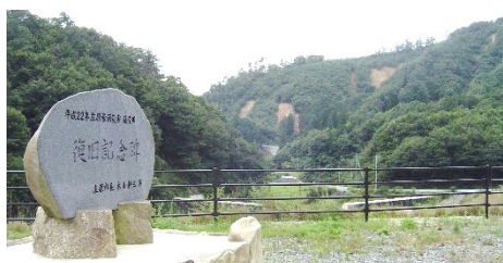
庄原市土砂災害現場 現地視察会
