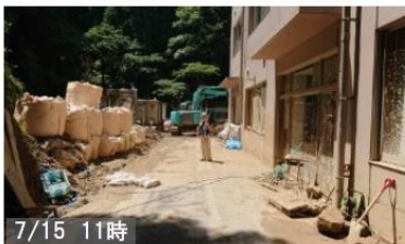
⑯大学施設内の被災状況 大学ホールは土砂が流入し窓 枠が損壊するなど被害が発生
