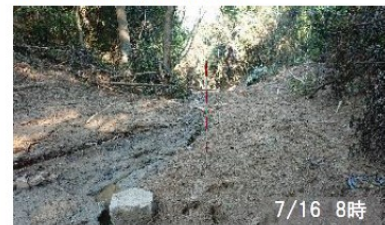
⑱土石流の流下区間 不安定な土砂が幅20m、厚さ 30cmほど残る区間
