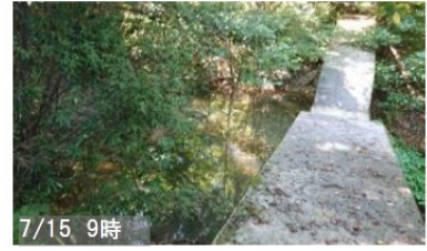
⑨被災箇所付近の治山えん堤 治山えん堤がある溪流は土石 流が発生しなかった
